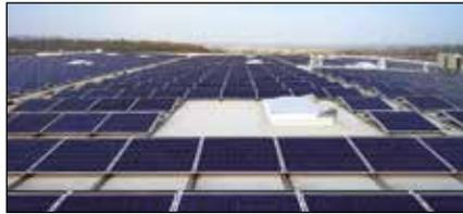
**Auf einer Fläche von rund 1.500 Quadratmetern erzeugen bei Oeding 900 Solarmodule Strom, der direkt im Gebäude genutzt wird.**
