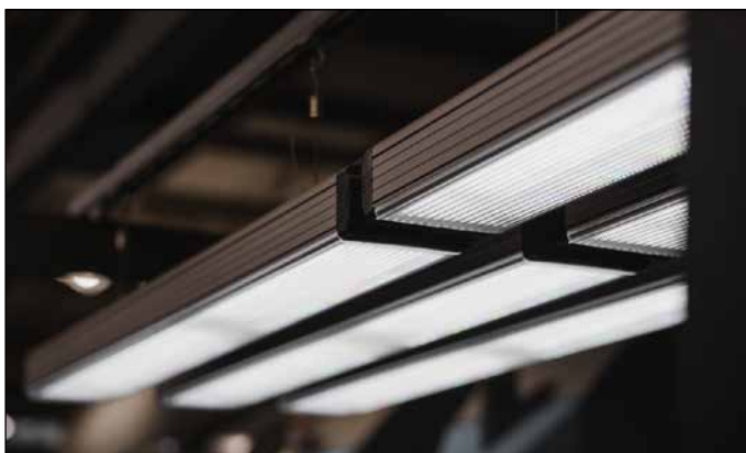
Die Umstellung auf LED-basierte Normlichtlösungen sorgt an den Produktionsstandorten der Klingele Paper & Packaging Group für eine sichere und objektive Farbbeurteilung.
